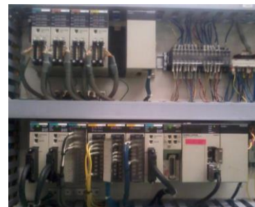
Gambar 12. komponen input dan output PLC yang digunakan untuk otomatisasi pergerakan table slide
